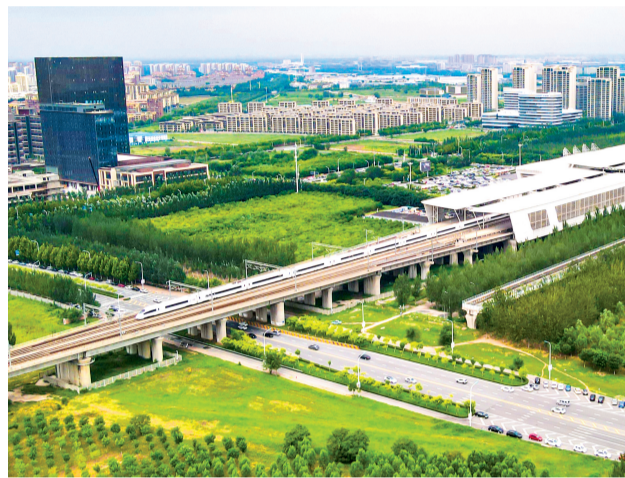
位于西青区的天津南站科技商务区。
