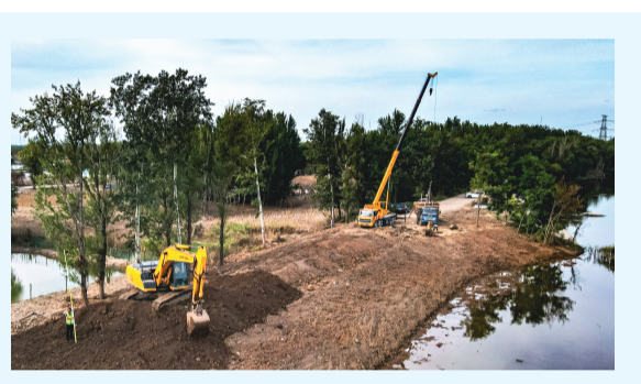
连日来,西青区辛口镇第六埠村抓紧进行洪水退去后的清理工作,开动挖掘机、装载机清理田间道路上的杂物,翻耕、晾晒土壤,以恢复农业生产。 本报记者 潘立峰 通讯员 袁忠清 摄
