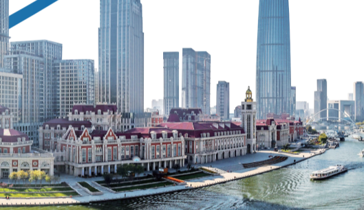
和平区纪委监委派纪检监察三组深入解放北路103-107号片区城市更新项目现场进行监督检查。
