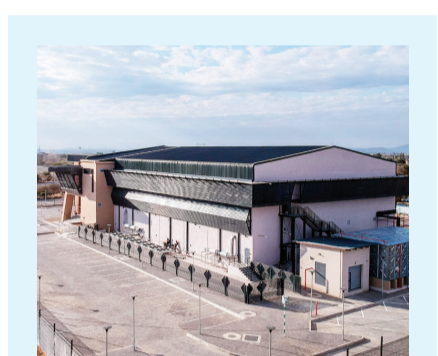
博茨瓦纳国家数据中心项目由中国江西国际经济技术合作有限公司博茨瓦纳分公司承建。该项目包含一栋两层数据中心大楼及其附属设施。目前项目进展顺利,承建大楼预计将于2023年10月完成竣工验收,交付给博茨瓦纳光纤网络公司。
