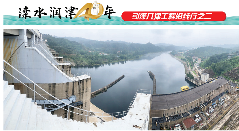
潘家口水库大坝。
