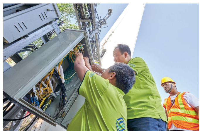
连日来，天津移动对区域内中断基站设备开展检测恢复工作。目前，已完成静海区台头镇和平村、建设村、南苗头村基站的恢复开通，保障滞洪区内居民回家后的网络通信。 本报记者 张磊 通讯员 冯蕾 摄
