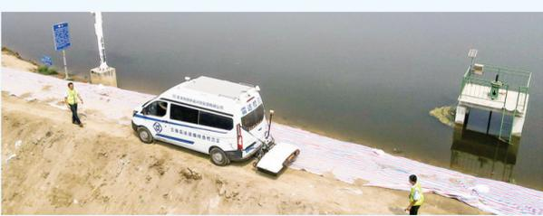
连日来,天勘集团派出由10余名技术骨干组成的天勘集团防汛抢险勘测技术服务突击队,提供现场防汛应急技术服务。利用车载三维雷达检测设备,对堤坝及上方道路进行扫描和数据采集,通过基准“体检”,及时发现薄弱环节、险工险段等,确保第一时间完成抢险施工,切实夯实堤坝根基,确保河道行洪安全畅通。
