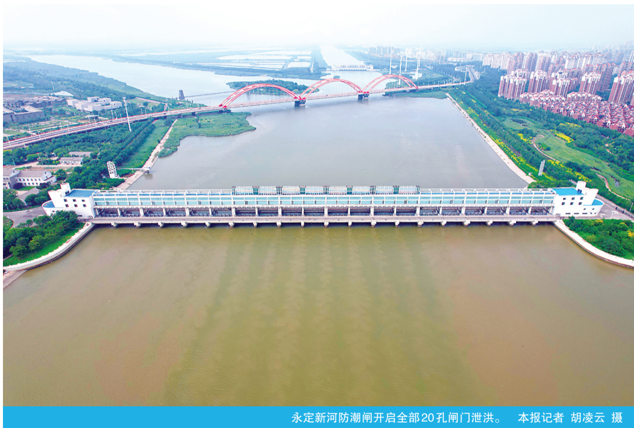
永定新河防潮闸开启全部20孔闸门泄洪。 本报记者 胡凌云 摄
