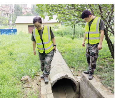
张敬(左)和刘海鹏正在永定河左堤查看穿堤涵管。
