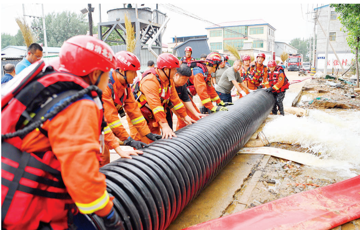
8月6日,在河北省涿州市刁窝镇东张村,唐山消防救援支队队员在进行排涝作业。
