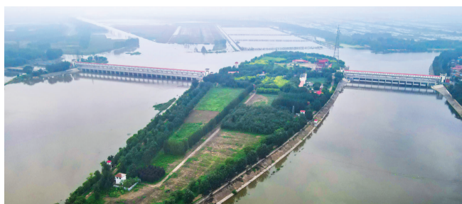
目前，位于大清河、子牙河与独流减河交汇处的独流减河进洪闸南、北闸36孔闸门全部提起。工作人员24小时值班值守，密切关注水位和流量变化。 本报记者 潘立峰 摄
