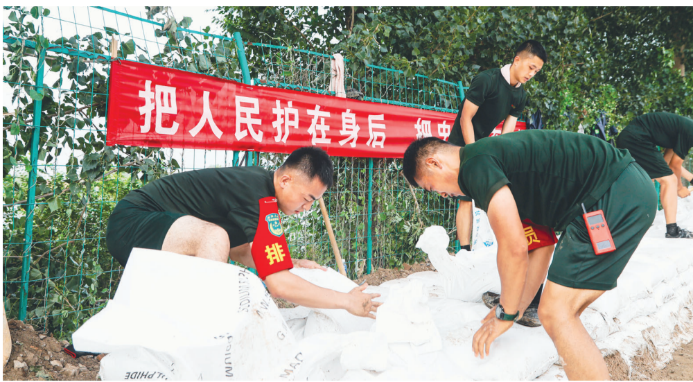
目前，静海区将抢护大堤安全作为首要任务，市、区各方面力量共同努力推动“三线作战”，进行大清河北堤和围埝加高加固工程。现场动用挖掘机推土机42台、运输车83台，作业人员5000余人昼夜奋战抗洪一线。 本报记者 潘立峰 通讯员 宋琨 摄
