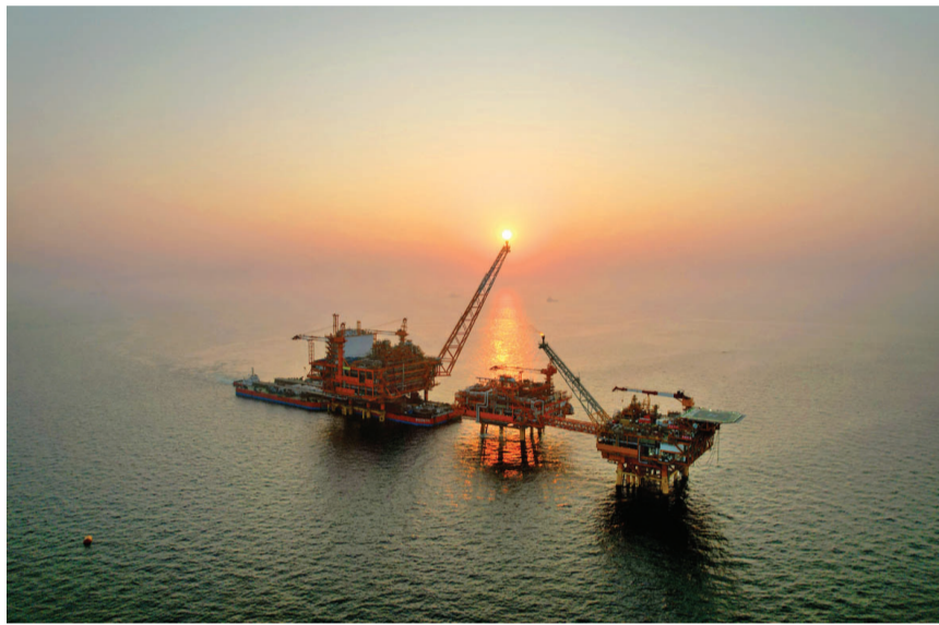
渤中19-6气田中心平台。
