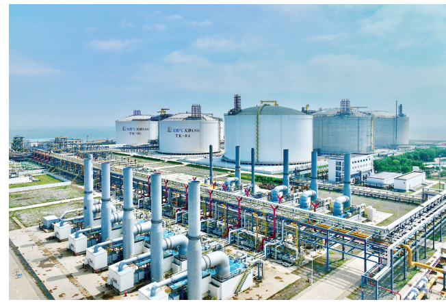
中国石化天津LNG接收站生产区域。 中国石化天津LNG接收站供图
