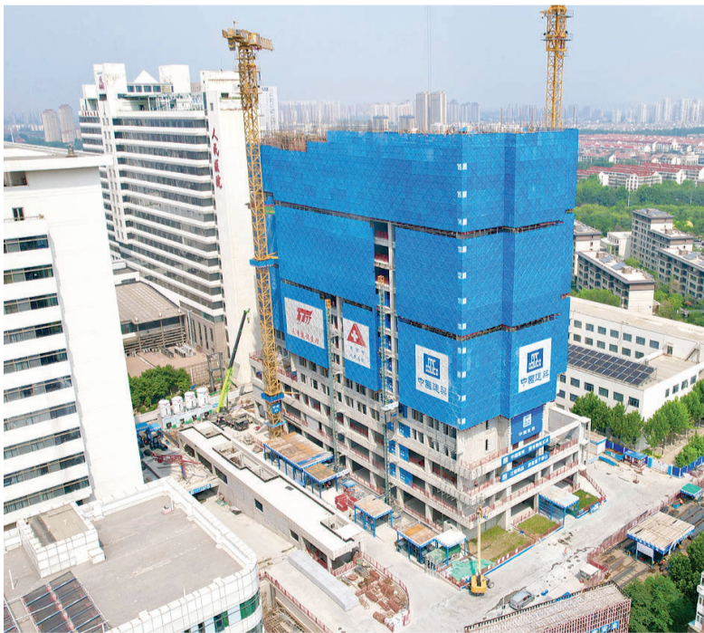
日前，市人民医院扩建三期工程(住院楼)实现主体结构全面封顶，计划于明年春节完工。 本报记者 张磊 通讯员 赵慕真 摄
