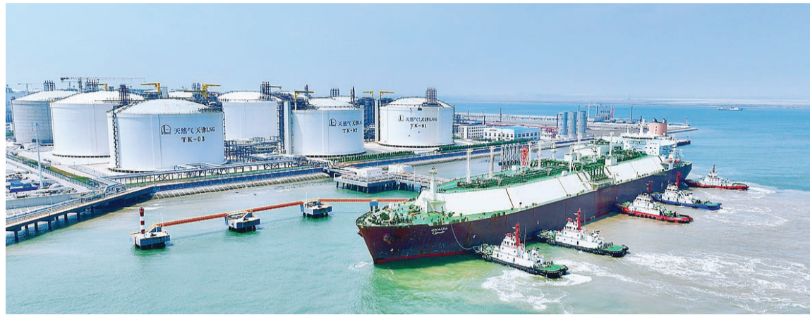
日前,来自卡塔尔的“奥切茶”号LNG运输船靠泊中国石化天津LNG接收站。
