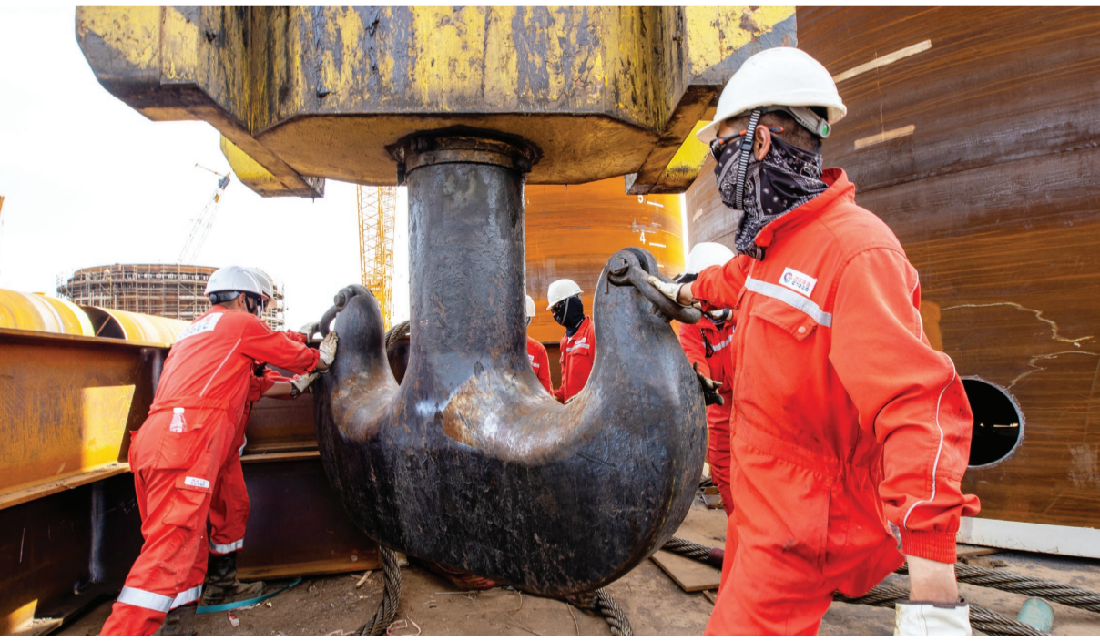
施工人员进行吸力锚吊装准备工作。
