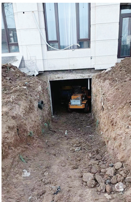
挖掘机清理地下空间(业主提供)。
