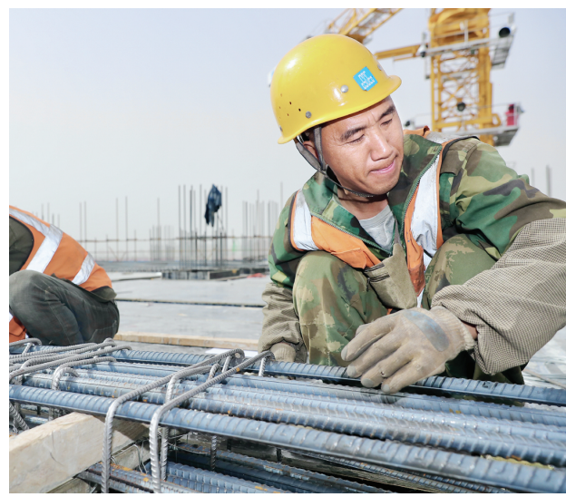
“五一”假期，中建三局建设者坚守在天津市人民医院扩建三期工程现场，确保工程早日完工交付，为市民提供优质的医疗服务。 本报记者 张磊 摄
