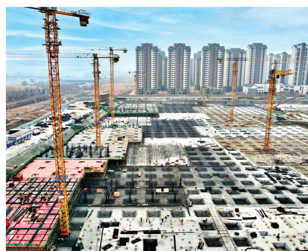
我市重点民生建设项目——中国一冶北辰区青光示范小城镇二期农民安置房项目正在进行地下室主体施工，计划2025年6月交付使用，项目建成后将改善4212户居民居住条件。本报记者 张磊 摄
