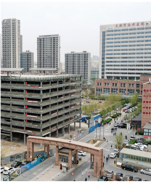
南开医院在建停车楼。
