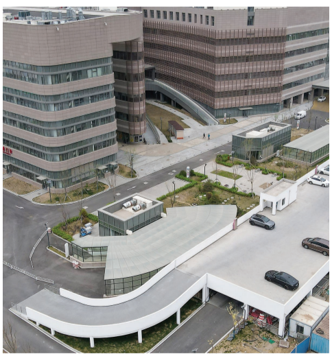
一中心医院水西院区地上停车场。
