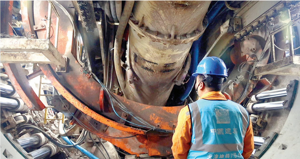
地铁7号线八里台站—六里台站区间开始盾构施工
