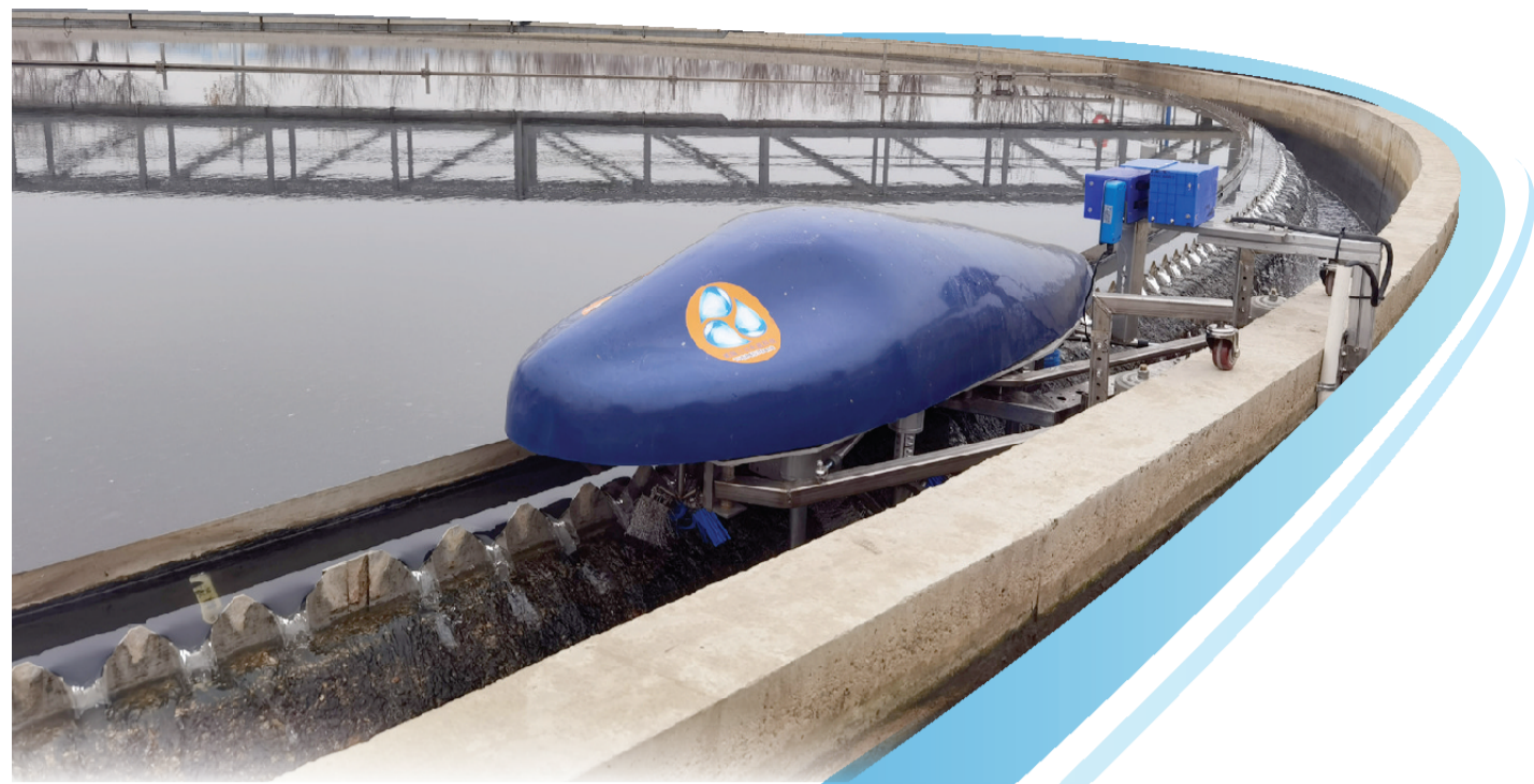
津沽污水处理厂清洁机器人。
