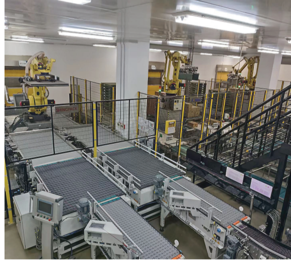
为方便拍摄临时开灯的机械臂工作区域。
