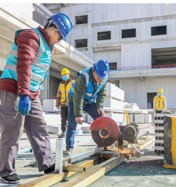
连日来,西青区各重点项目建设开启“春忙模式”。图为张家窝镇市民运动中心施工现场。本报记者 潘立峰 通讯员 袁忠清 摄
