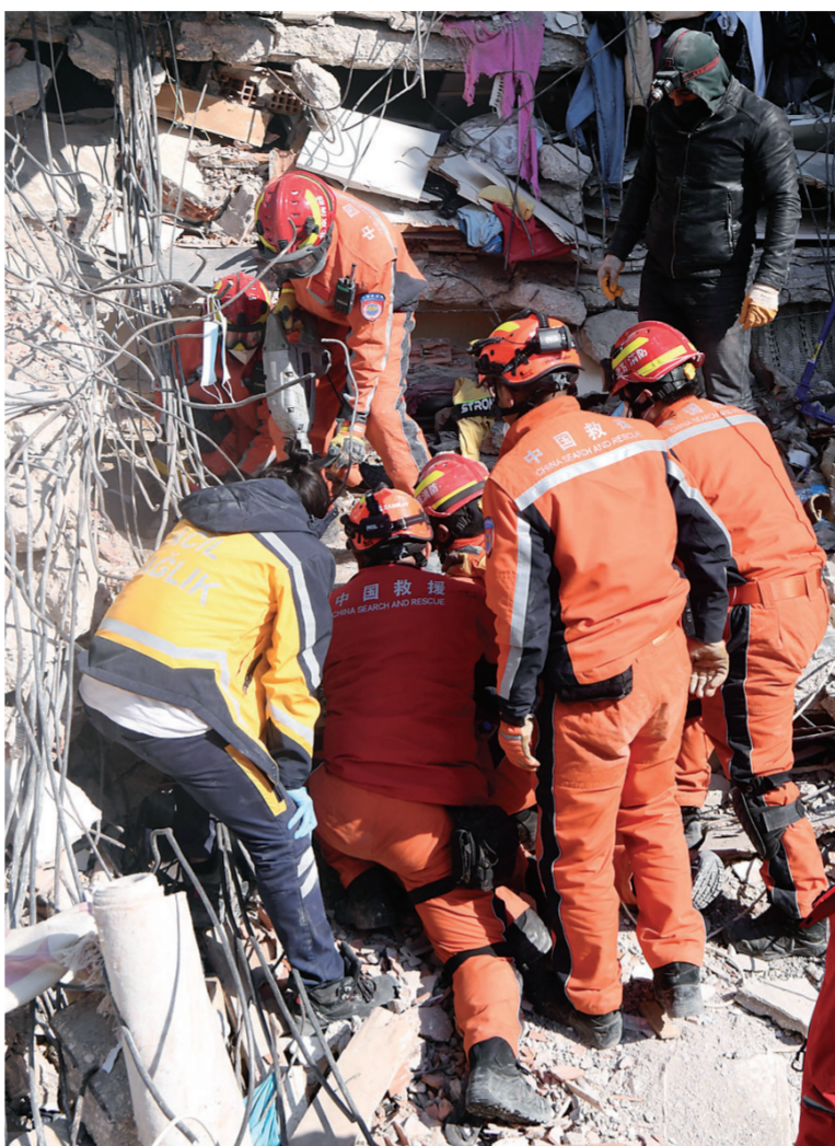
12月12日,中国救援队队员在土耳其哈塔伊省安塔基亚市一处地震废墟开展救援工作,已救出六名幸存者。新华社发
