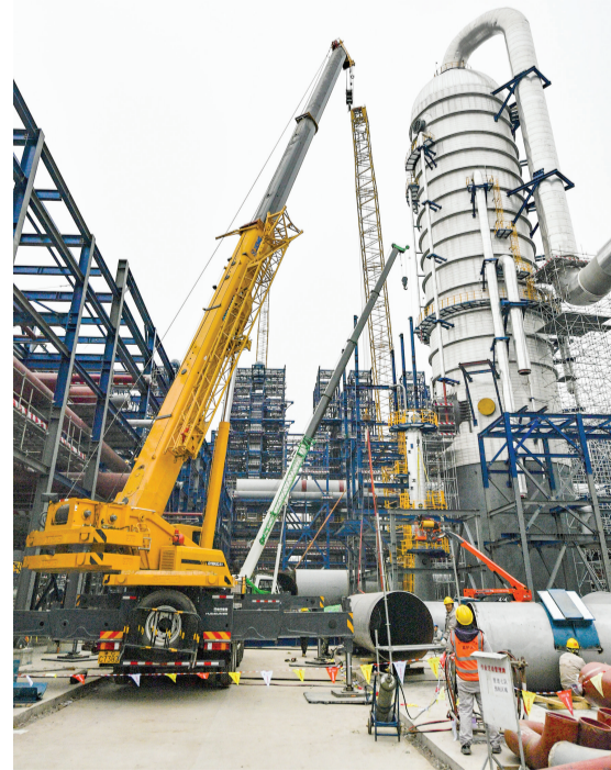
位于天津南港工业区的天津石化120万吨/年乙烯及下游高端新材料产业集群项目进入建设加速期,9000多名建设者参与建设,保障施工进度。
