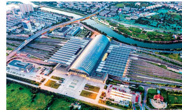
天津西站俯瞰图。红桥区供图
