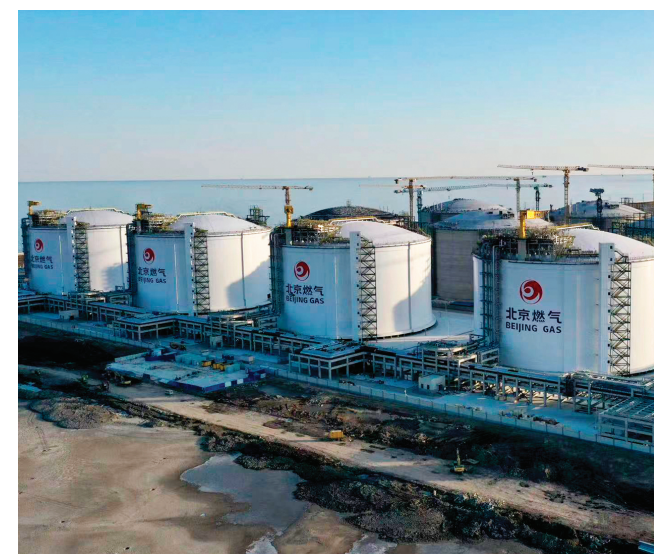
正在建设中的北京燃气天津南港液化天然气应急储备项目。照片由北京燃气天津南港液化天然气应急储备项目部提供
