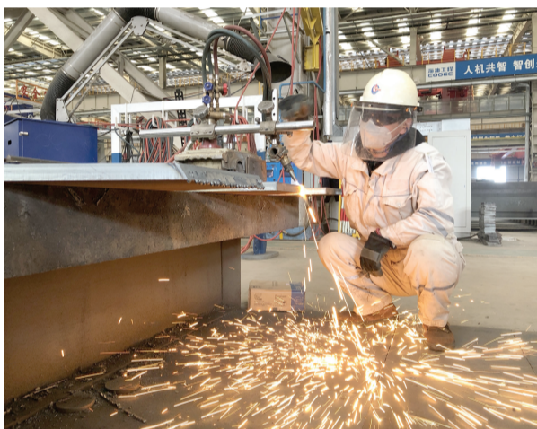
在海油工程天津智能化制造基地结构预制车间,施工人员正在切割钢板。
