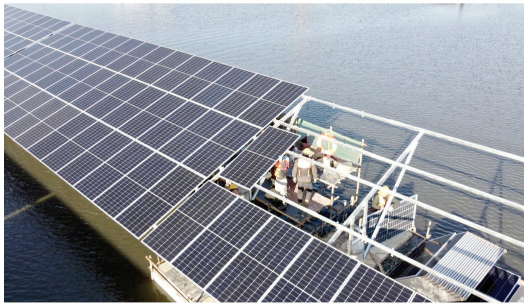
元旦假期,中建三局总承包安装公司百余名施工人员奋战在我国最大单体“盐光互补”光伏项目——华电海晶光伏项目现场。项目计划今年3月完工投用,届时可形成“水上光伏发电、水面蒸发制卤、水下水产养殖”的立体循环生态模式。本报记者 张磊 摄
