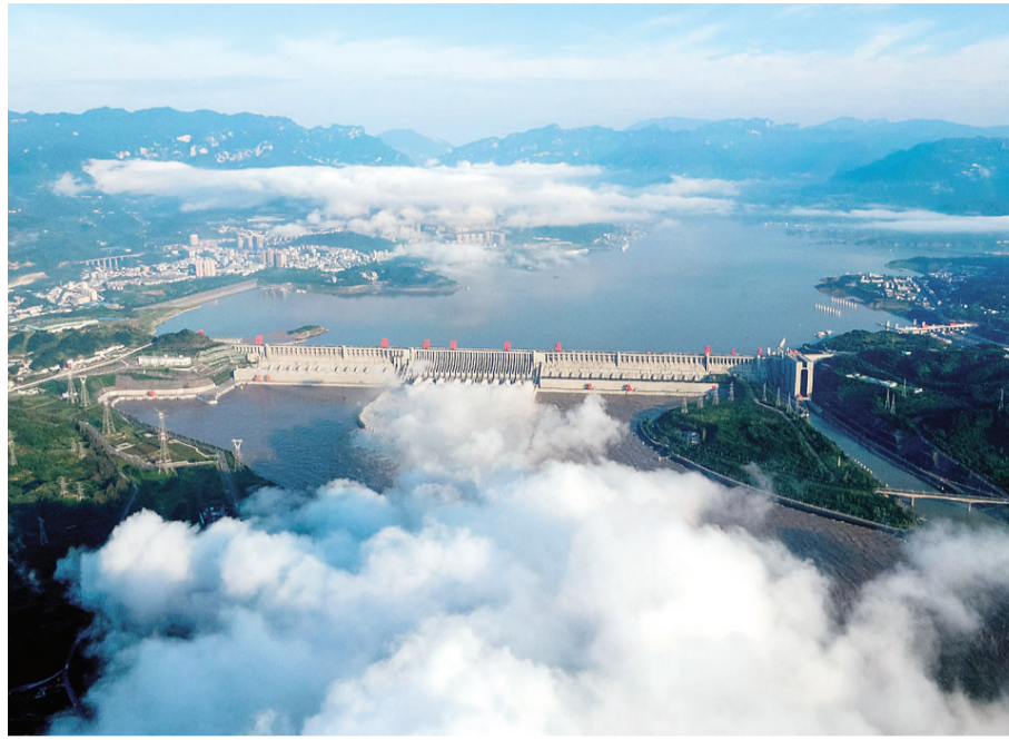
▶图为2020年8月19日拍摄的长江三峡水利枢纽工程开启泄洪深孔泄洪(无人机照片)。 新华社发
