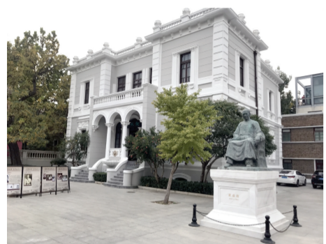
修缮完成的梁启超纪念馆。照片由馆方提供
