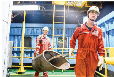
夜班人员正在进行滤网清洗作业,无论严寒酷暑,他们都要日复一日地重复这项工作,确保生产流程的稳定运行。
