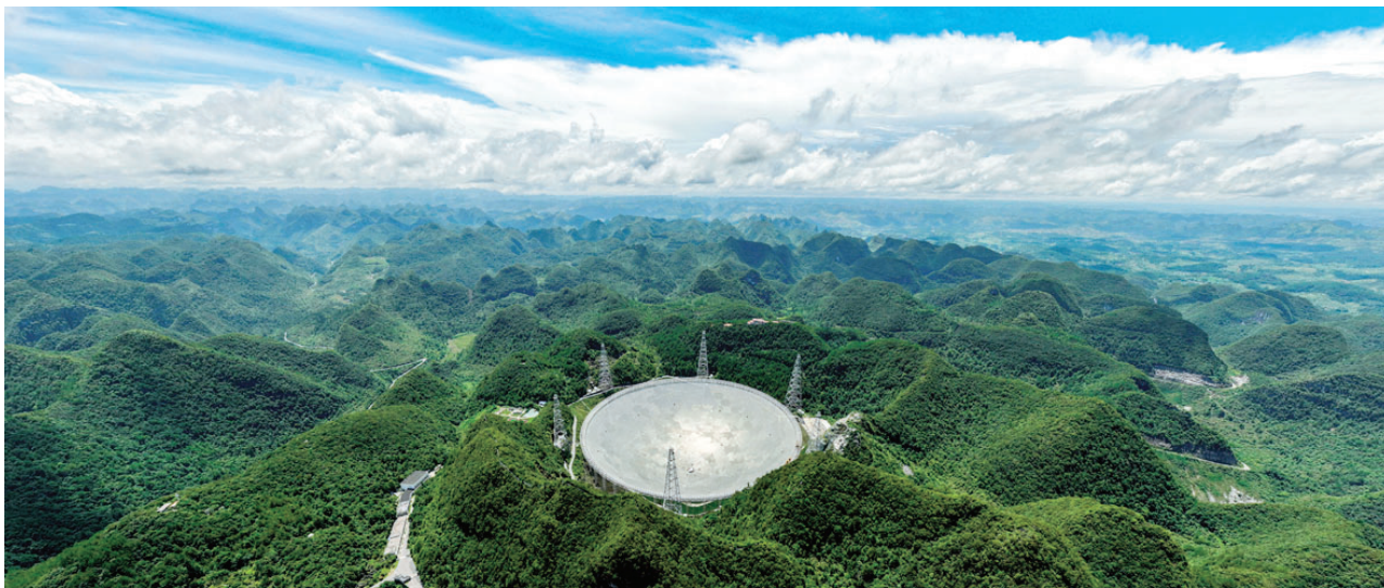
这是“中国天眼”全景（2022年7月21日摄，维护保养期间拍摄，无人机照片）。
