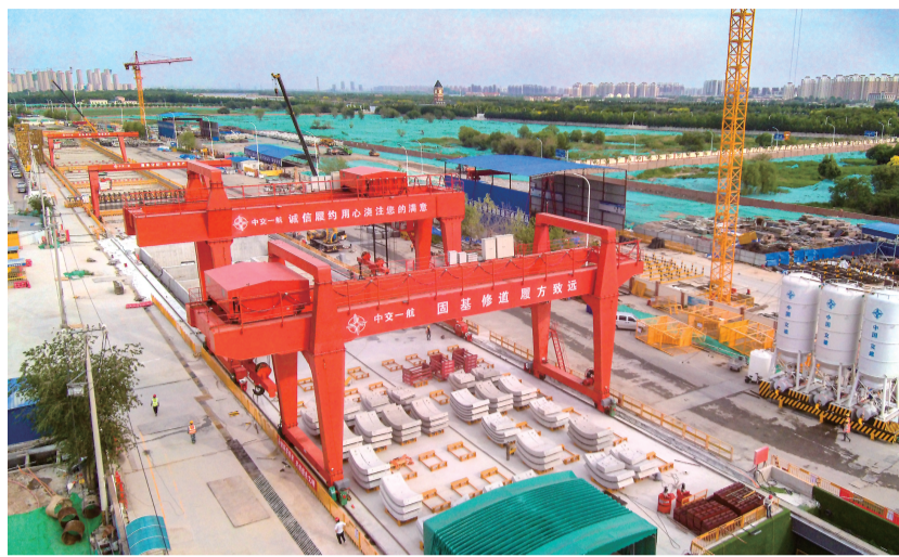
天津地铁11号线6标管项目-雪莲南路站
