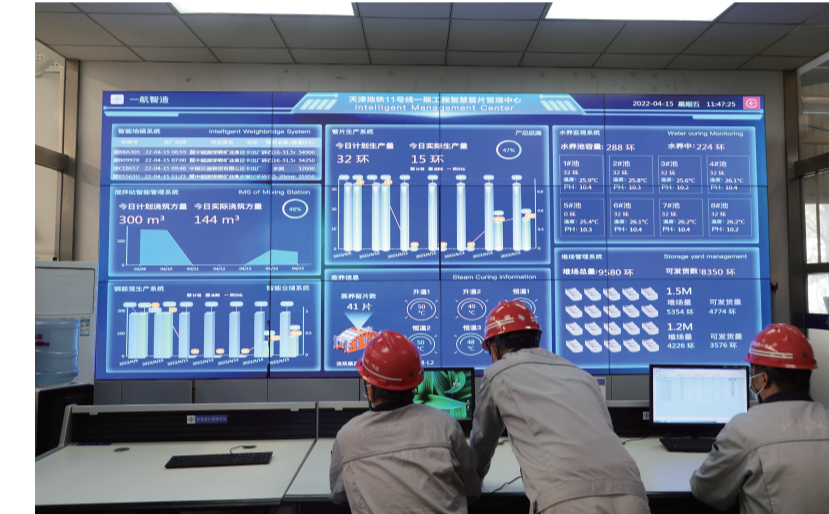
天津地铁11号线10标管片厂-智慧管理中心
