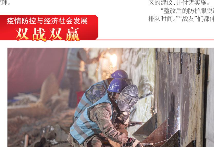
由中建六局轨道公司建设的天津地铁7号线天塔站和肿瘤医院站正在全力推进复工复产工作。图为肿瘤医院站项目已全面进入主体结构负三层中板施工。
