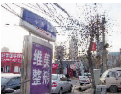
线缆凌乱垂路面
