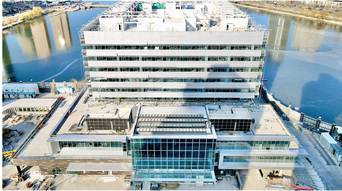
天津市环湖医院原址改扩建工程外檐施工正在紧张进行，春节前将全部完成，并于明年交付使用。
