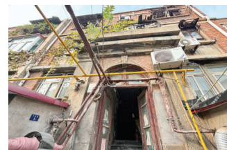
记者拍摄的兴中里5号楼
