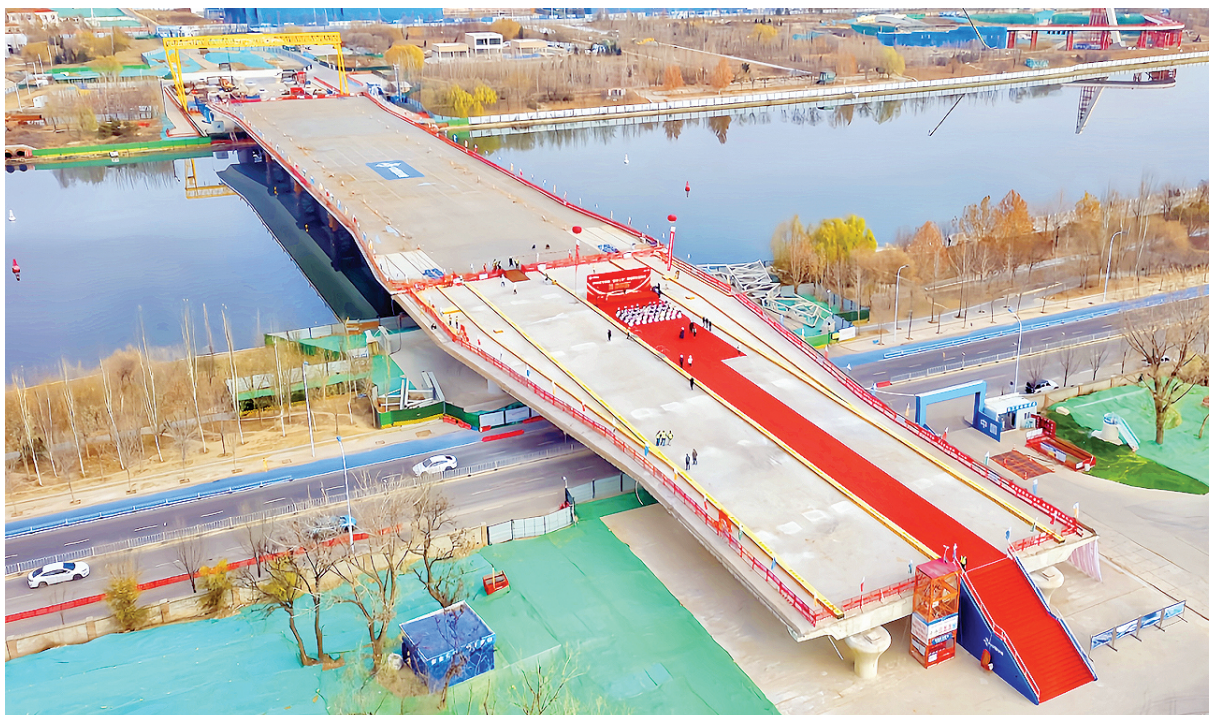
柳悦桥工程主桥实现合龙
