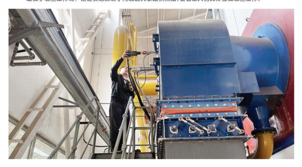
河北区天泰路供热站,是本市规模较大的一家供热站,目前覆盖了河北区四个街道的供热,供热面积覆盖达到了560万平方米,今年的实际供热面积在480万平方米。因为供热面积大,天泰路供热站下辖着60多个换热站。正式供热开始后,热水要先从天泰路供热站出发,进入到一次管网,到达换热站,再由换热站进入到二次管网,最后进入到居民家中。目前的冷态运行,通俗解释就是让管道里的水运行起来,虽然水不热,但是可以对管道等设备进行检测,一旦出现问题好及时处理。
