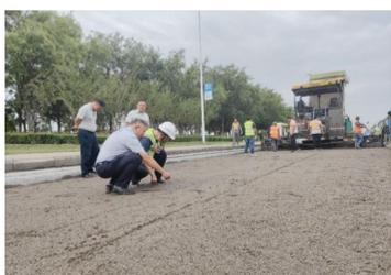
红桥等区近2000吨的生活垃圾被送往中节能垃圾焚烧发电厂，经过焚烧后产生约400吨炉渣，用于本次养护作业。堆放在厂区的炉渣先要经过筛分、破碎，将其中没有焚烧掉的废铁等杂质清理出来，再用水清洗去除粉尘，形成直径在5-10毫
