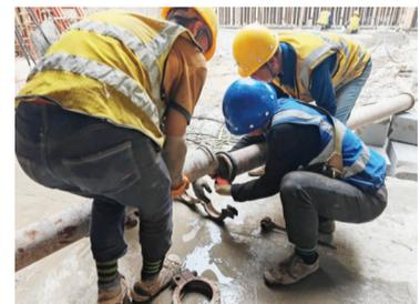
进行连续监测。同时,抢险人员结合现场情况,有序开展沙袋封堵、基坑抽水、渗漏注浆等工序。两小时后,“险情”得到有效控制。
