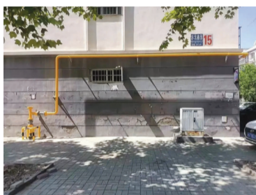
千米,架空管道6.5千米,燃气管道气源切换工作也已完成。
